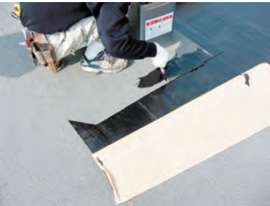
ラップボンド施工例
