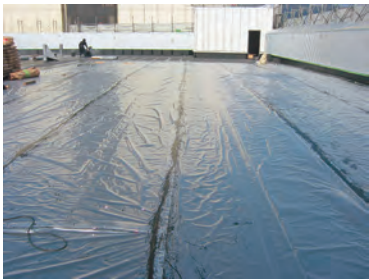
絶縁スワシート施工例
