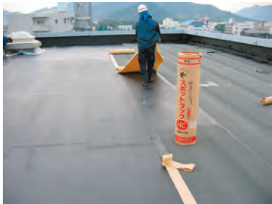
スポットタックHC施工例
