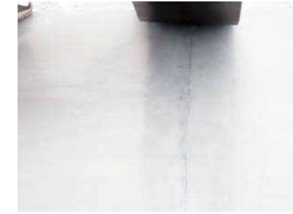
②スポットタックCの長手方向は突付け後、アスタックベース1号B W200mmにて増張り。
