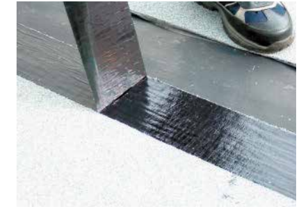
③アスタックルーフSラップ部のフィルムを剥がす。
