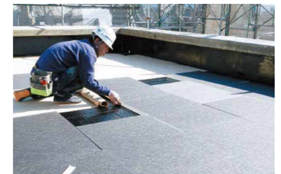
モイスポット張付け後、断熱材T張付け
