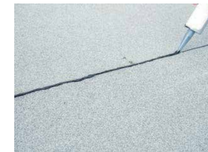
⑤アスタックルーフS端部にナノアスボン塗布。
