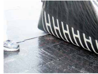
①下地処理後、スポットタックCを張付け。幅方向は100mm以上張重ね。
