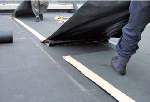
スポットタックHC 施工例
