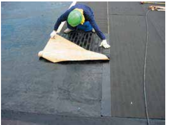
スポットタックHC 施工例
