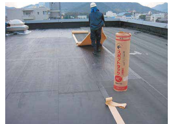
スポットタックHC 施工例
